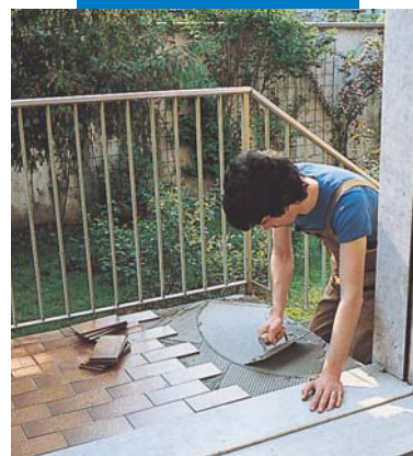
Хидроизолация, изравняване и полагане на настилка с Kerabond T+Isolastic
