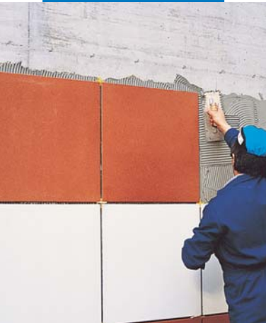
Полагане на големи по размер плочки с Kerabond T+Isolastic
