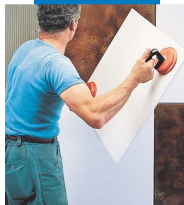
Полагане на KERAION върху стена
